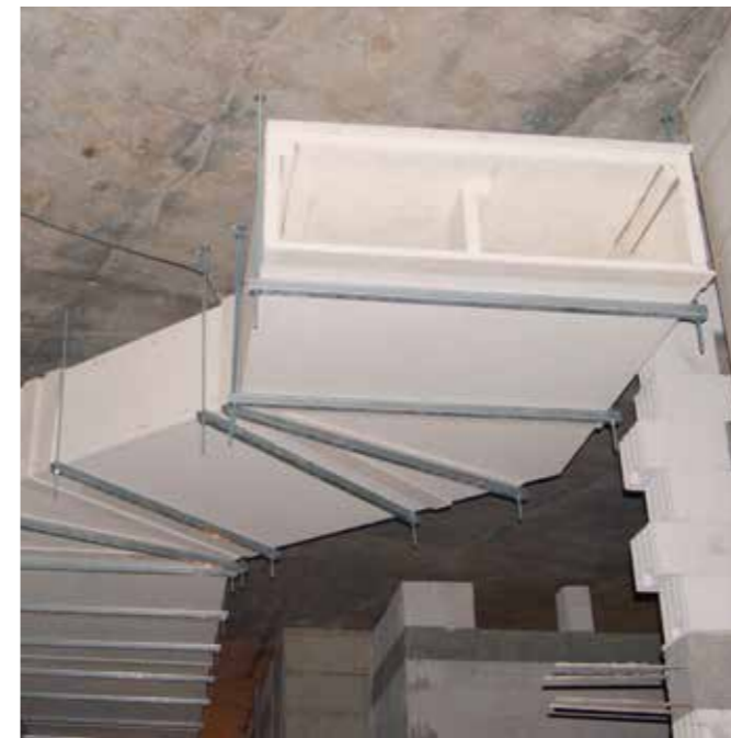
7 pav. Sienos kirtimo vietos apsaugos būdai
