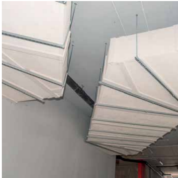
44 pav. PROMATECT®-L500 plokščių tvirtinimas prie šachtos sienų
