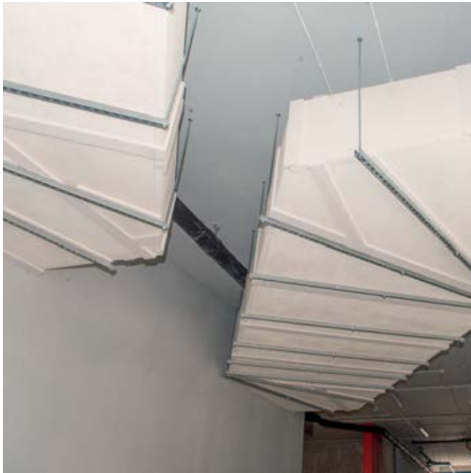
44 pav. PROMATECT®-L500 plokščių tvirtinimas prie šachtos sienų
