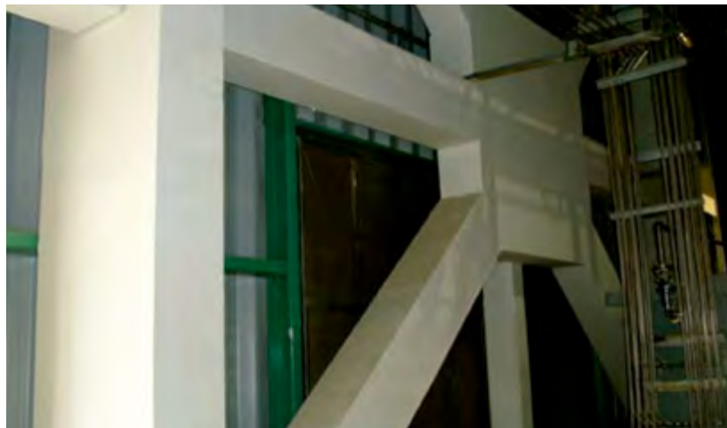
Revestimiento de columna y viga de acero estructural PROMATECT®-H en el edificio de oficinas One Shelley Street (arriba) en Sydney, Australia y Tatan Power Point, Taiwán (izquierda).
