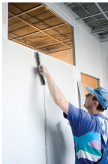
Obdelava spojev plošč v predelnih stenah (zgoraj levo) in spojev stene in stropa (zgoraj desno)
