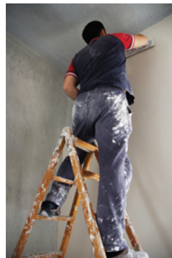
Obdelava spojev plošč v predelnih stenah (zgoraj levo) in spojev stene in stropa (zgoraj desno)
