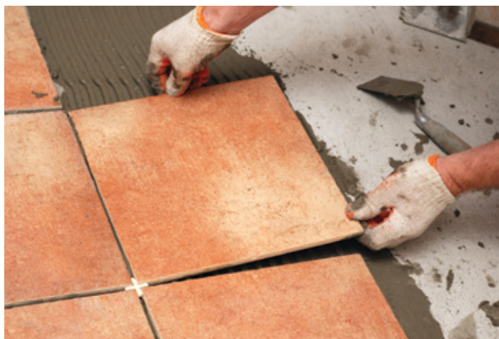
Nanašanje lepila za ploščice na predhodno montirane Promat plošče pred oblaganjem s ploščicami
